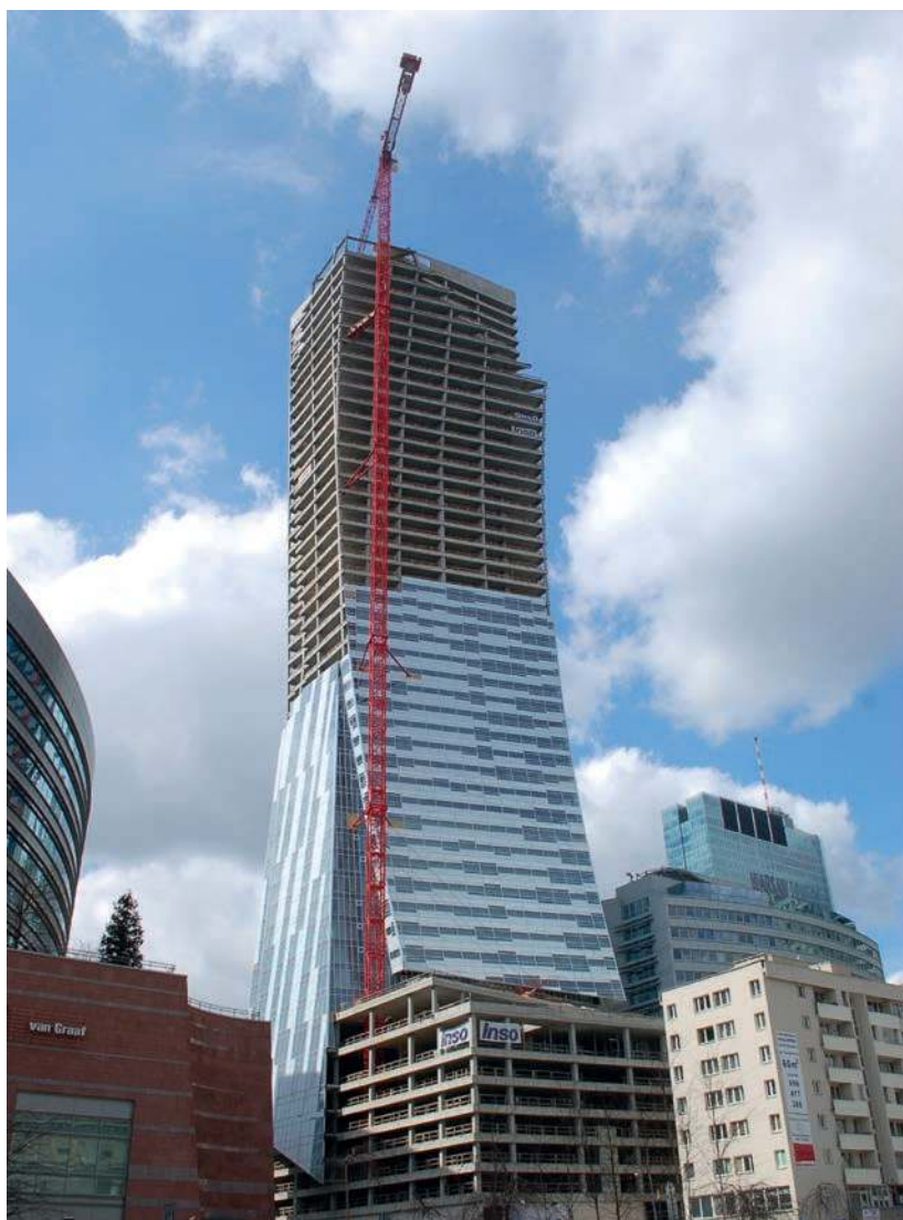
Okładanie fasady wieżowca panelami, październik 2021, fot. Wistula, źródło: Wikimedia Commons
