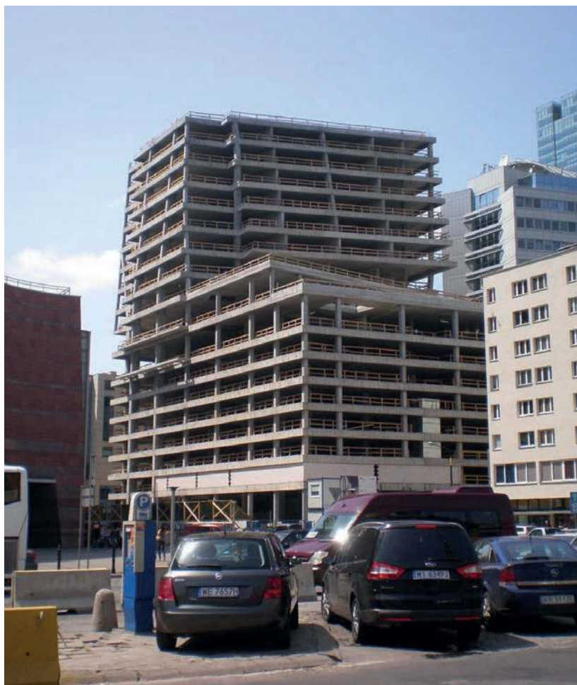
Wczesna faza budowy wieżowca przy Złotej 44, 2009, źródło: Fotopolska
