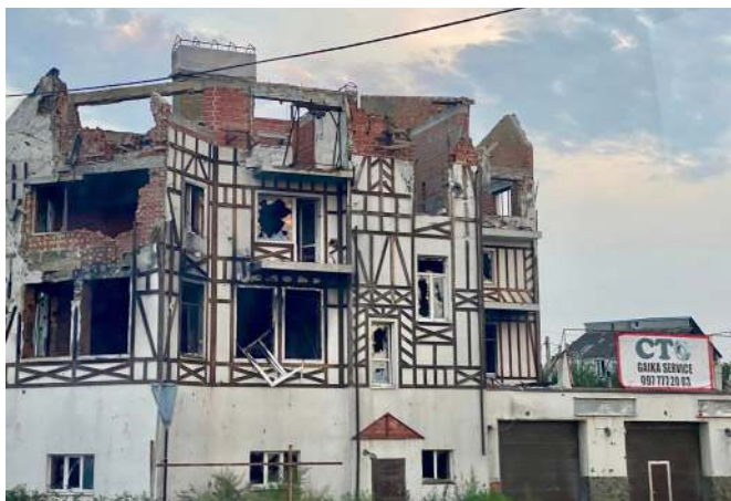
Зруйновані будівлі у Гостомелі, Київська обл., серпень 2022 року. Фото авторки статті
