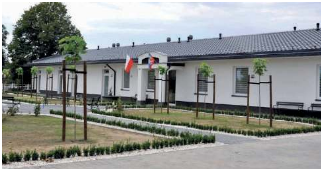
Inwestycja została sfinansowana w ramach Solidarnościowego Funduszu Wsparcia Osób Niepełnosprawnych. Na budowę centrum przeznaczono kwotę ponad 2,5 mln zł
