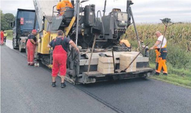
Prace nad nową nawierzchnią
