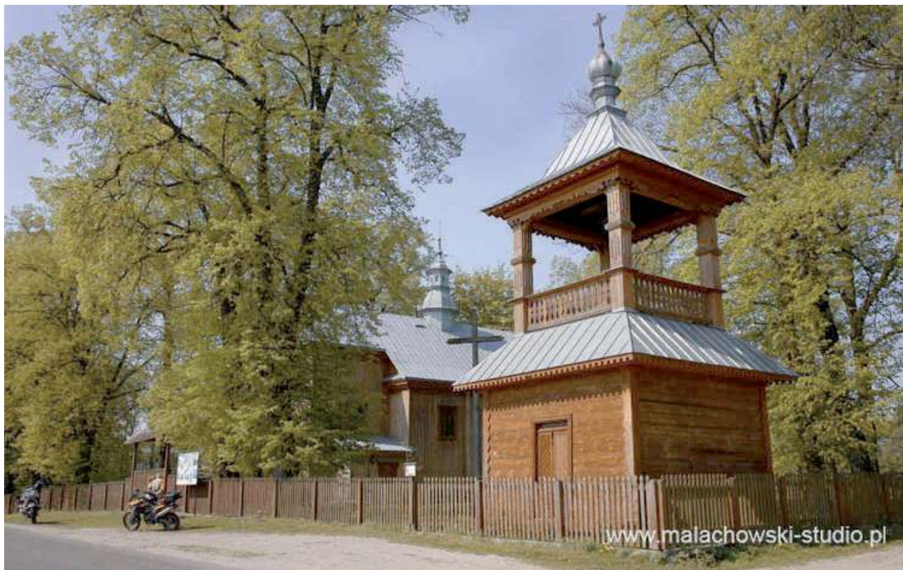
Dzwonnica i kościółek Zmartwychwstania Pańskiego w Bezwoli - stan obecny, kościółek odbudowany po pożarze
