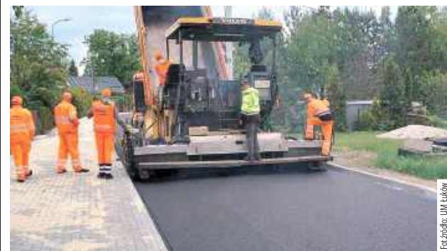
Zakończenie wszystkich prac zaplanowano na 12 czerwca
