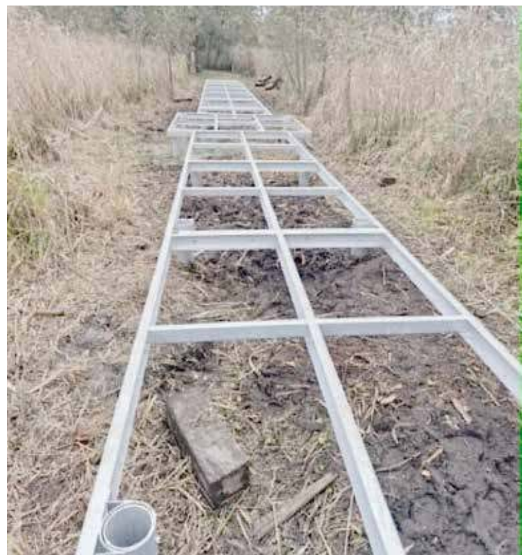
Most stalowy w budowie... Wykonawca prace zakończy najprawdopodobniej w listopadzie
