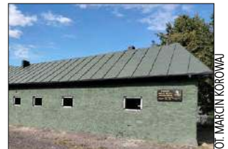
Na zewnątrz stacji będzie utwardzony teren, będzie utworzony parking, miejsce apelowe
