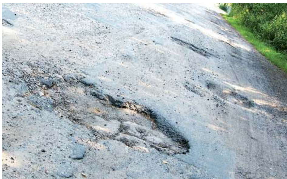
Prace drogowe są prowadzone w różnych miejscowościach, szczególnie na drogach, które wymagają interwencji i uzupełnienia ubytków
