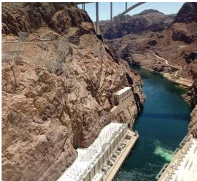
Elektrownia w zaporze Hoovera
