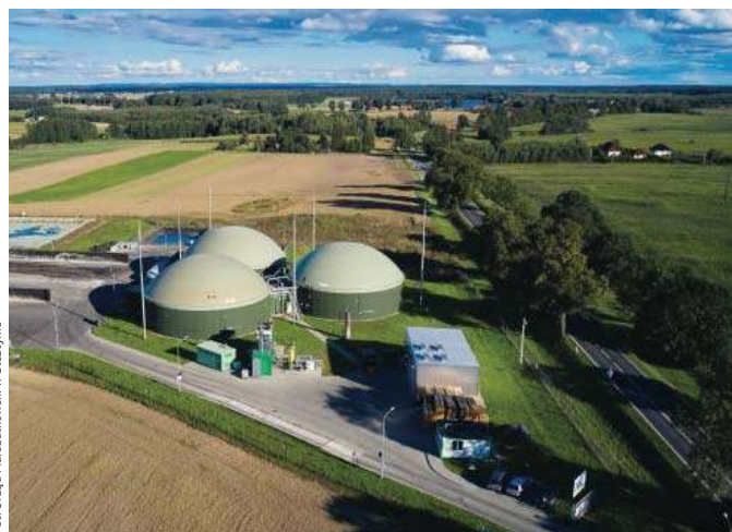
Budowa elektrociepłowni na biogaz w Falkowie, gm. Susz. RPO WiM 2014-2020
