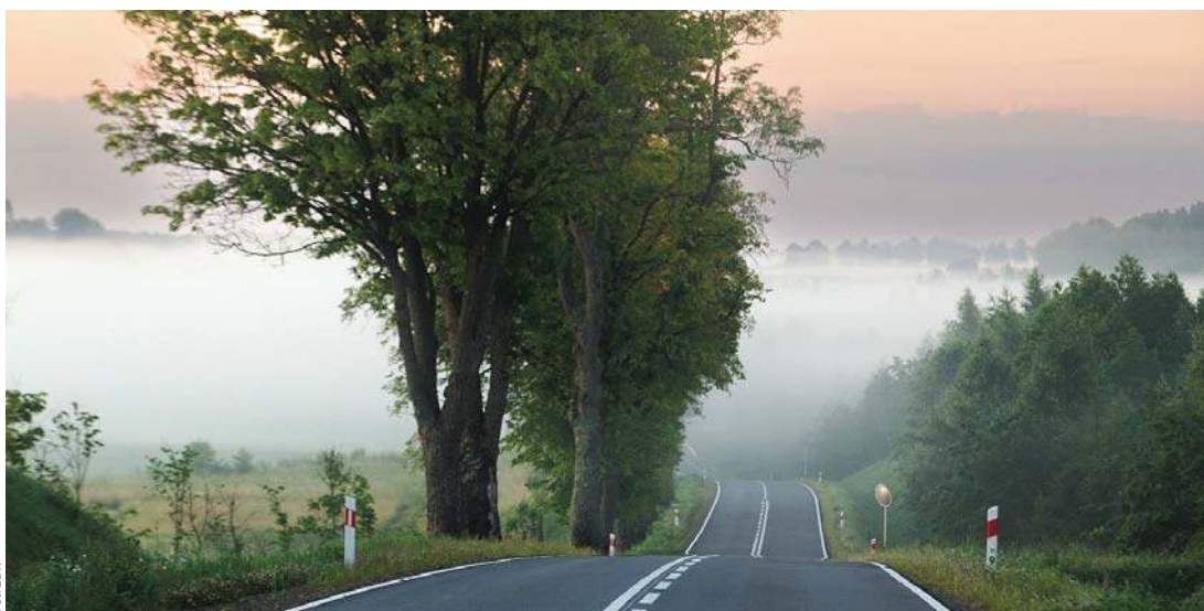
Rozbudowa drogi 512 Pieniężno-Bartoszyce. RPO WiM 2014-2020
