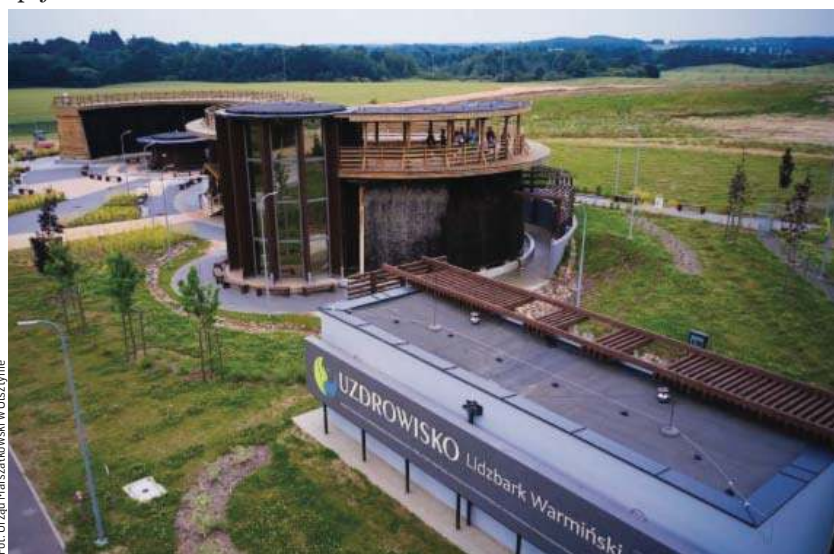
Budowa infrastruktury uzdrowskiej w Lidzbarku Warmińskim. RPO WiM 2014-2020
