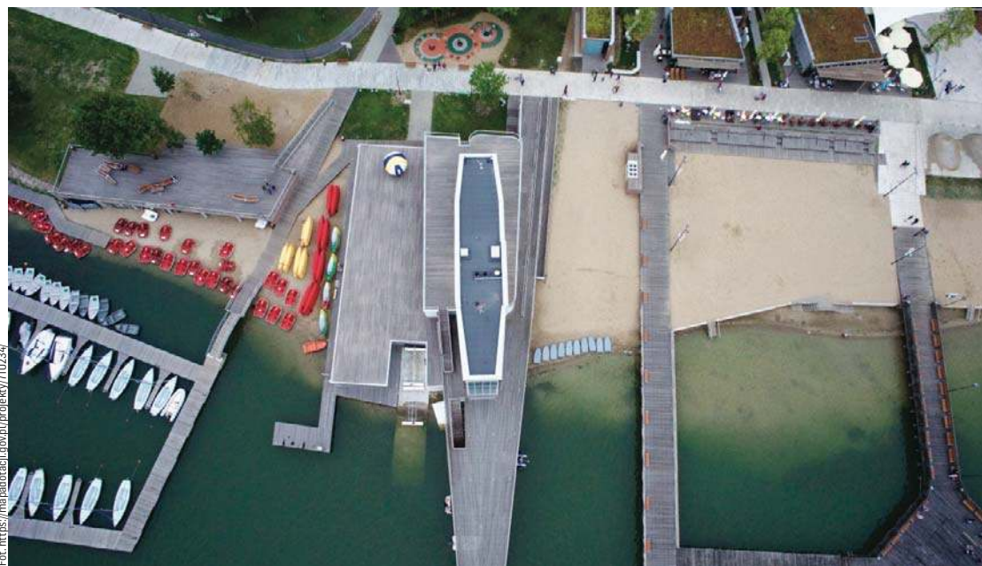
Budowa infrastruktury sportowo-rekreacyjnej nad Jeziorem Krzymym w Olsztynie. RPO WiM 2007-2013
