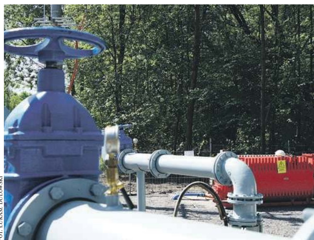
Pompy w lesie w rejonie Grunwaldzkiej pompują wody gruntowe, które...
