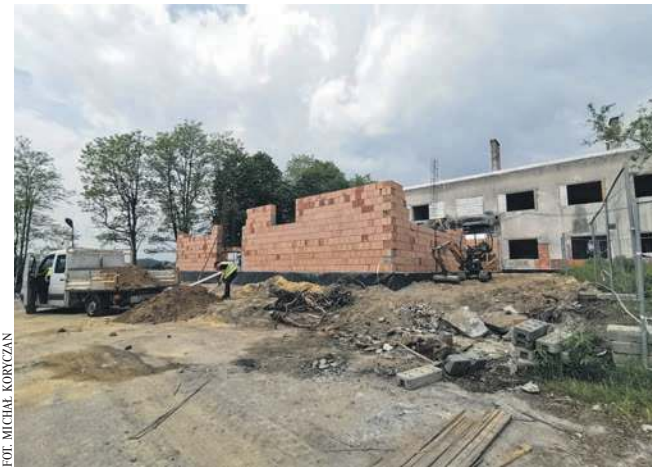
Trwa przebudowa budynku na potrzeby gospodarki komunalnej
