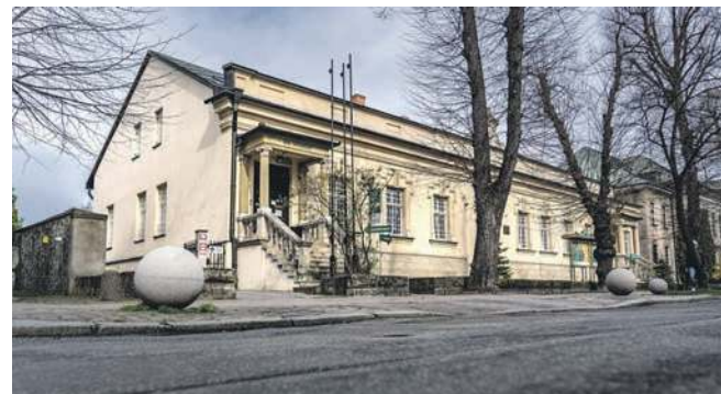
Widok budynku od al. Henryka
