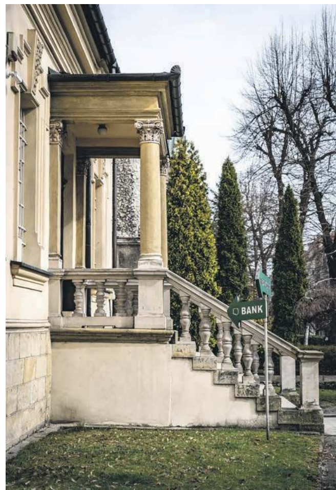
Wejście główne do budynku
