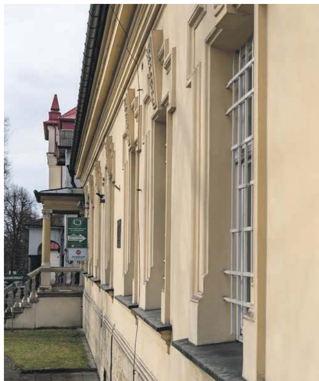
Zdobienia wokół okien na ścianie frontowej
