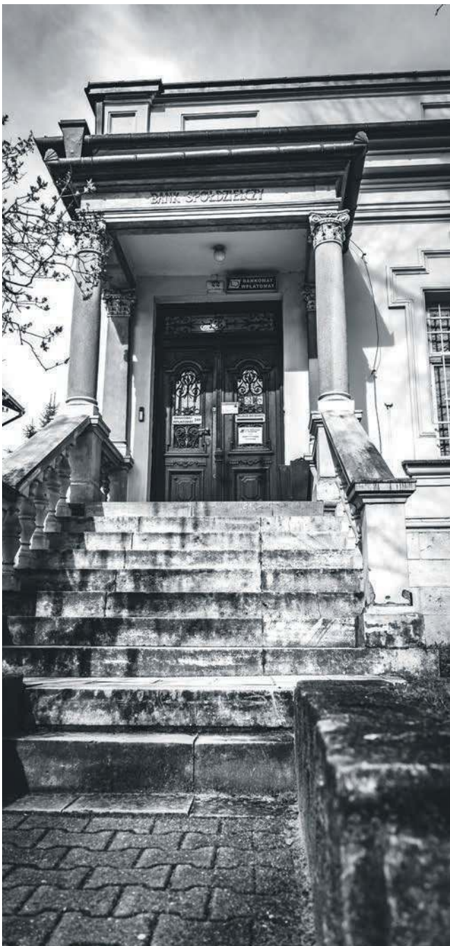
Kamienne schody wiodące do wejścia
