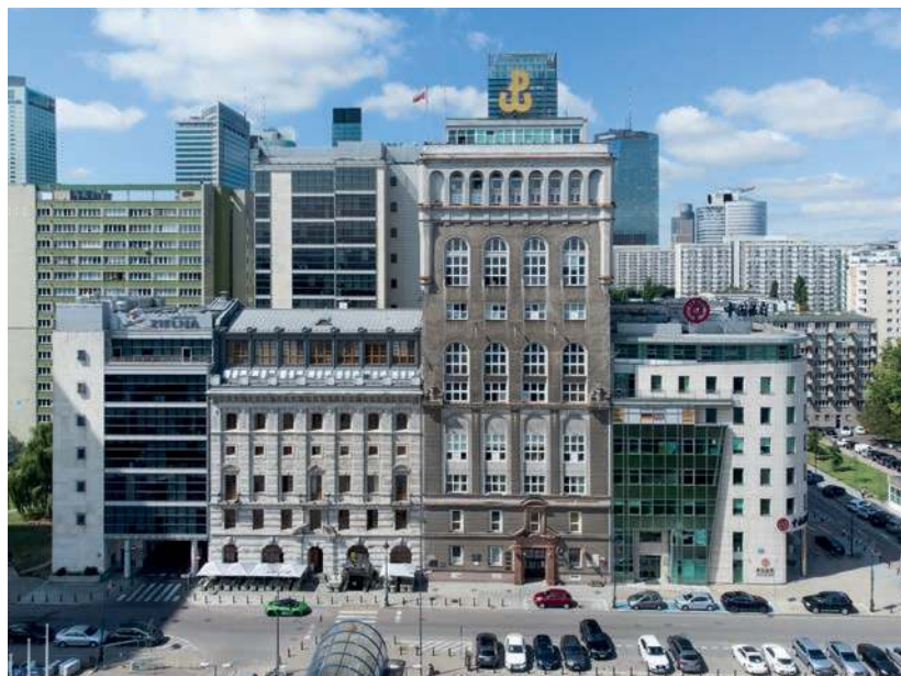
Budynek PAST-y, widok od strony wschodniej, źródło: Wikimedia Commons
