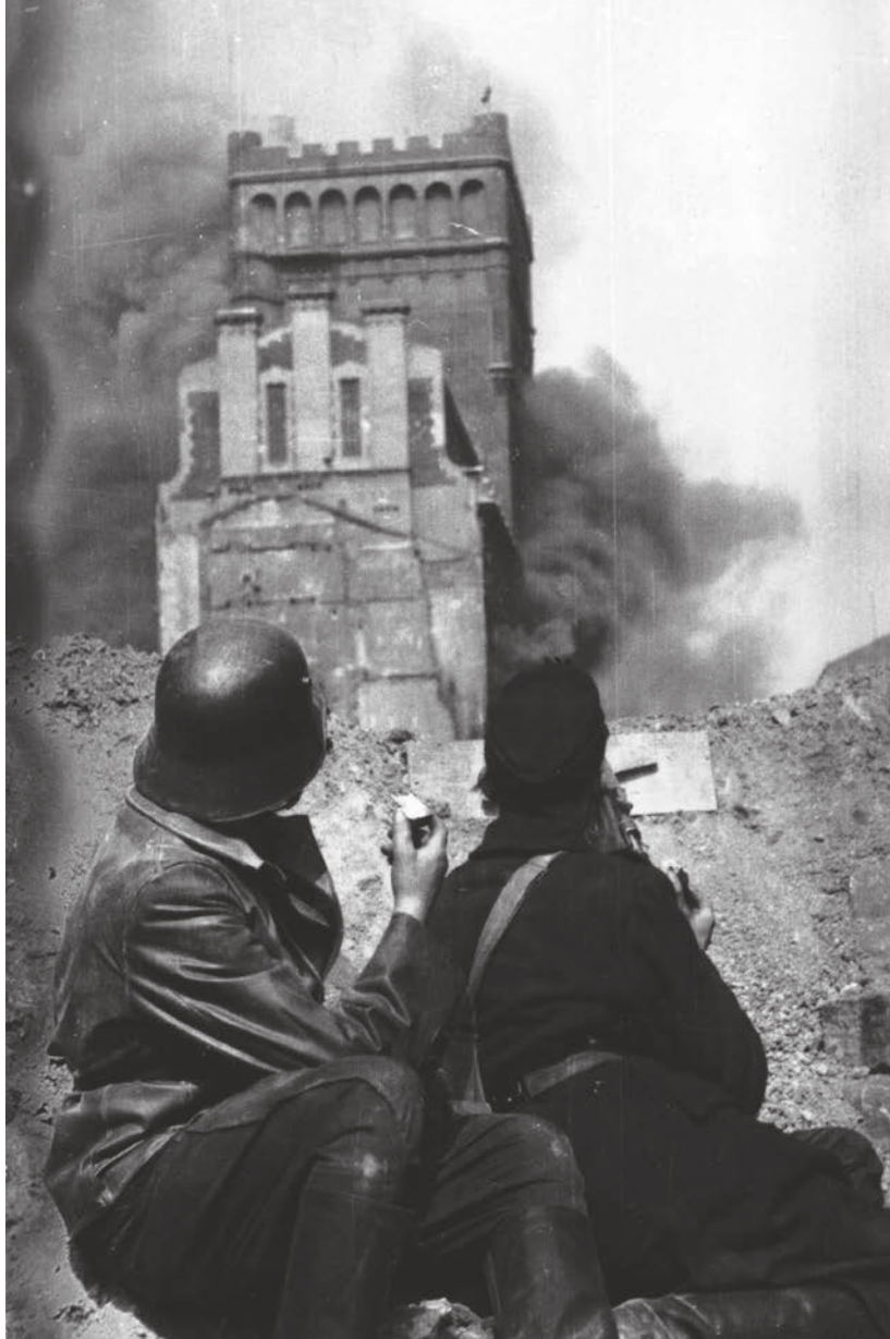
Powstańcy z batalionu „Kiliński” na barykadzie na ul. Zielnej obserwują płonący gmach PAST-y. Fot. E. Lokajski, źródło: domena publiczna
