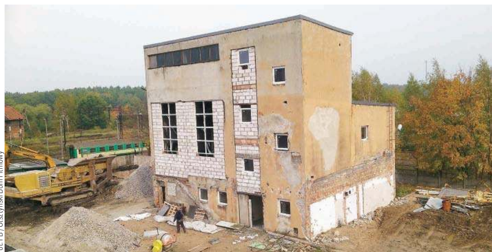
Przed i po remoncie
