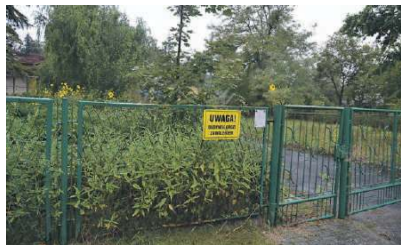
Na razie na działce przy ul. Gisgesa wciąż stoi opuszczony budynek przedszkola „Żaczek”. Jednak, jak zapewniają prezes Sądu Okręgowego w Tarnobrzegu Szymon Rożek i burmistrz Niska Waldemar Ślusarczyk, budowa nowej siedziby dla sądu i prokuratury ruszy najpóźniej w przyszłym roku
