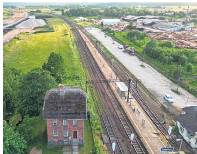
Modernizacja linii nr 202 ze Słupska do Lęborka z 10-miesięcznym opóźnieniem
