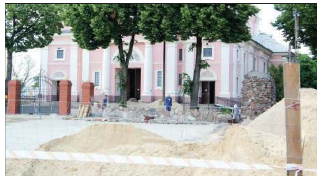
✚ Prace trwają nie tylko na Rynku, ale również przebudowywane jest ogrodzenie przy kościele parafialnym
