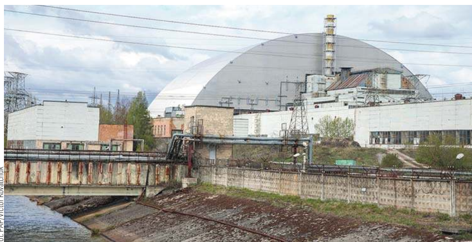
Kopuła nad zniszczonym czwartym blokiem energetycznym Czarnobylskiej Elektrowni Jądrowej
