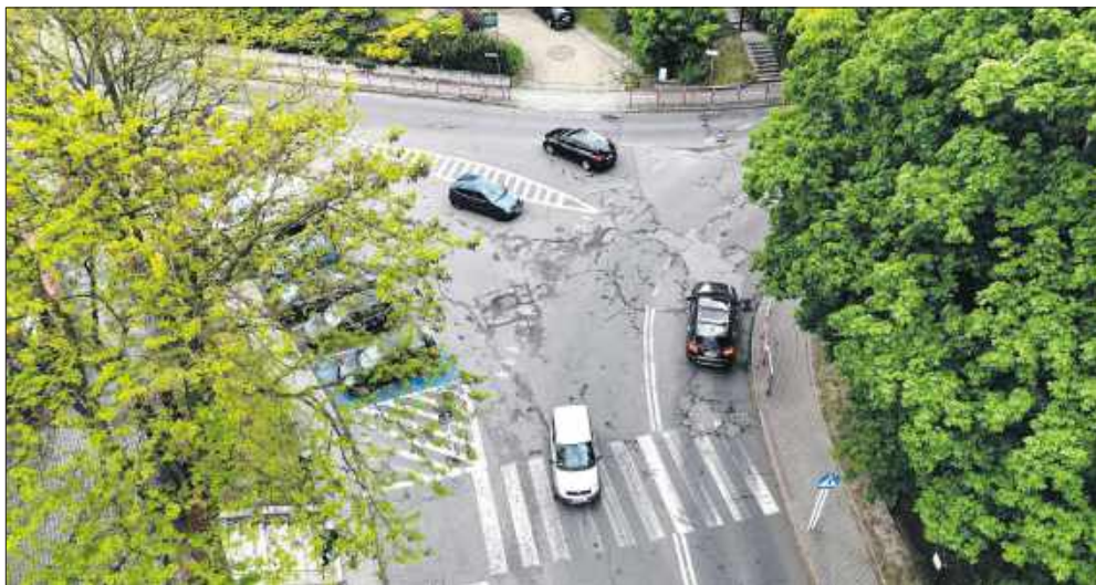
■ Przebudowa skrzyżowania ma odczuwalnie poprawić płynność ruchu i bezpieczeństwo.
