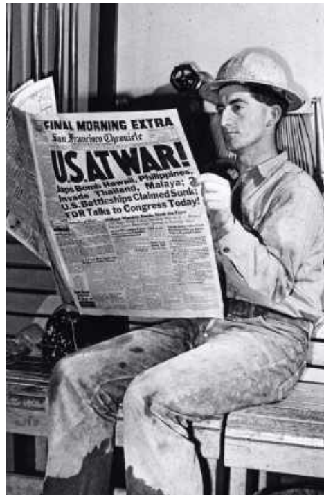
„San Francisco Chronicle” z informacją o zbombardowaniu przez Japończyków Pearl Harbor; na budowie zapory Shasta w Kalifornii, grudzień 1941 r.
