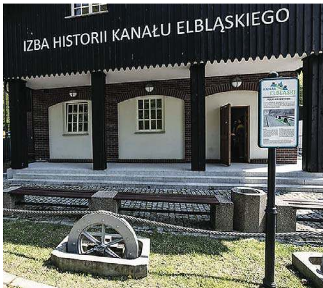
Budynek Izby Historii Kanału Elbląskiego w Buczyńcu
