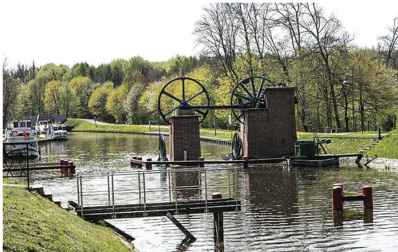
Koło wodne obraca się tylko w jednym kierunku obrotu bębna linowego
