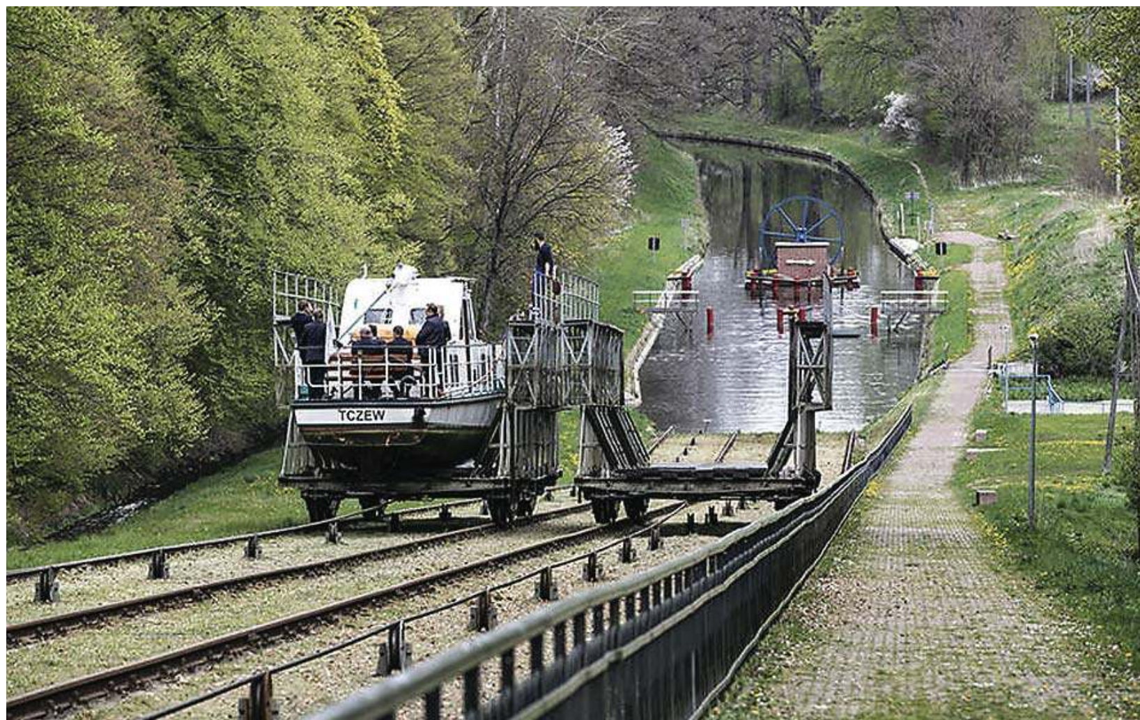
Jednostka pływająca pokonuje różnicę poziomu po torowisku ułożonym na specjalnym wózku
