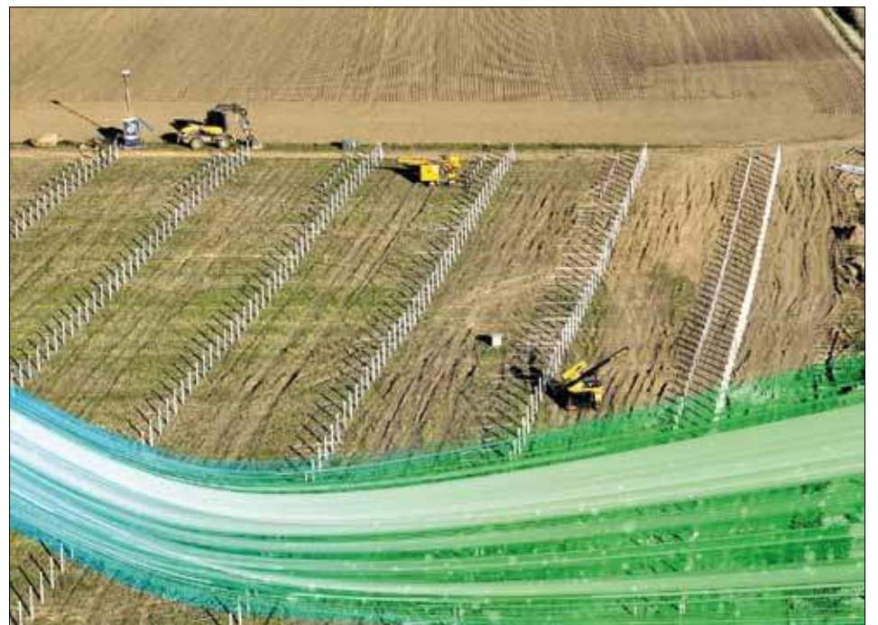
Budowa farmy fotowoltaicznej Dygowo I
