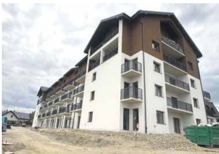
Budynek komunalny przy Kilińskiego jest już niemal gotowy.
