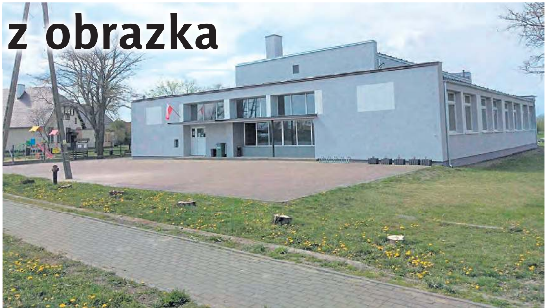
Odnowiona elewacja budynku domu kultury w Wielkiej Kloni.
