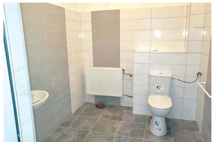
Pomieszczenie sanitarne zyskało nowy blask.
