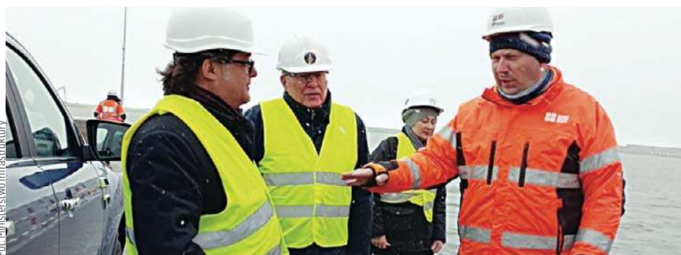
Marek Gróbarczyk odwiedził teren budowy w miniony wtorek
