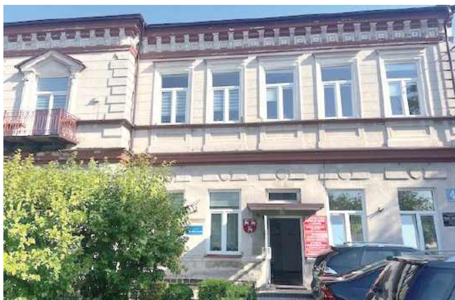
Odnowienie elewacji, modernizacja instalacji elektrycznej, przeniesienie skrzynki gazowej, wymiana drzwi - takie zmiany czekać będzie budynek starostwa
