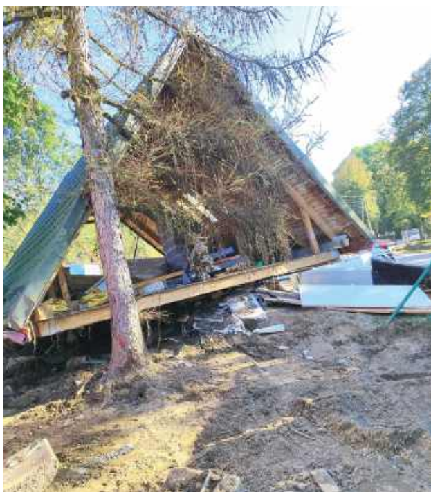
Takie zniszczenia poczyniła powódź
