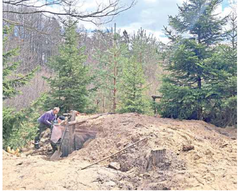
Bunkier w trakcie rekonstrukcji
