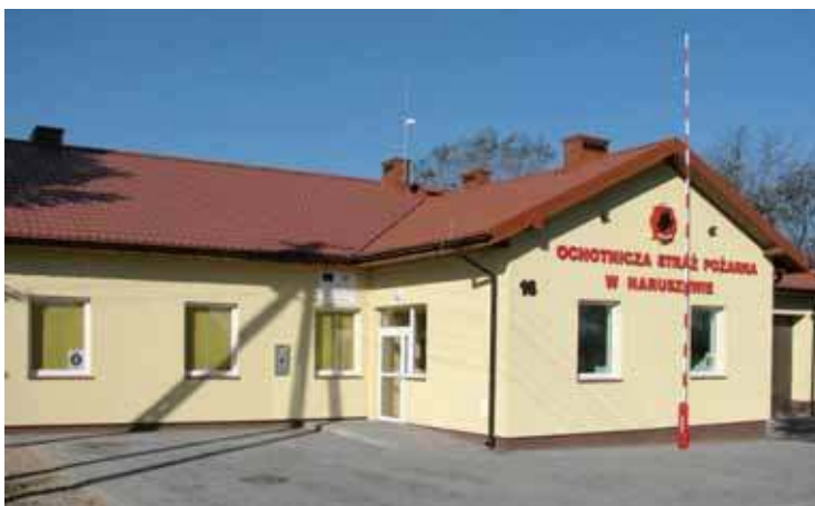
Remont remizy OSP Gmina Naruszewo
