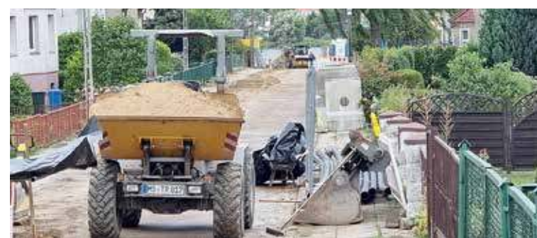
Na miejscu pracuje już ciężki sprzęt
