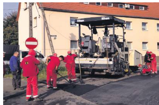
Ostatnie prace na remontowanej ulicy w Przewornie...
