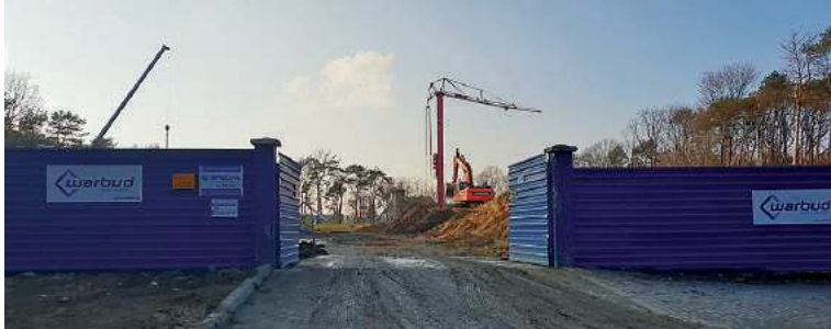
Plac budowy przy ulicy Fabrycznej
