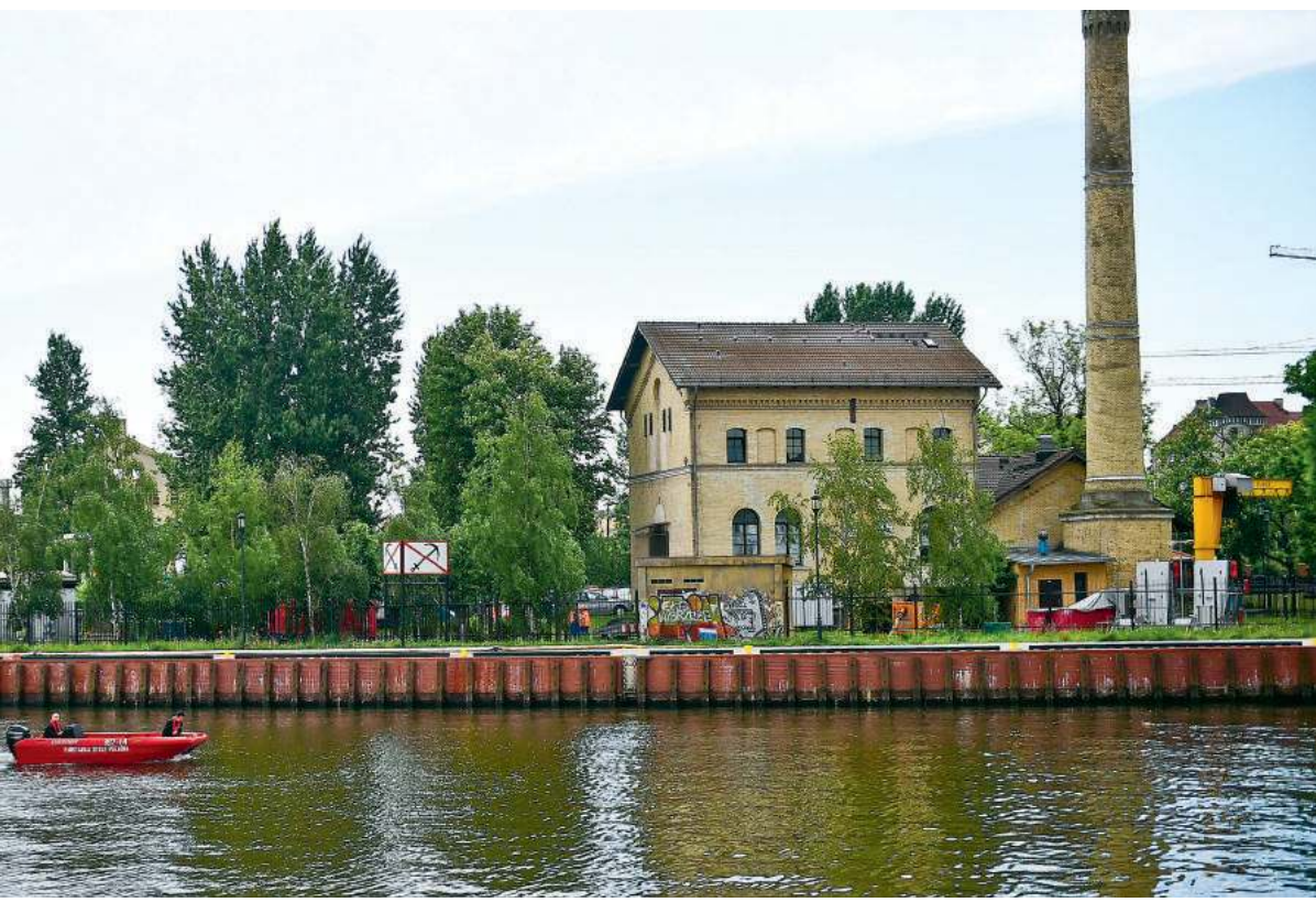
Przepompownia ścieków na Ołowiance | fot. Fotomag/Gazeta Polska
