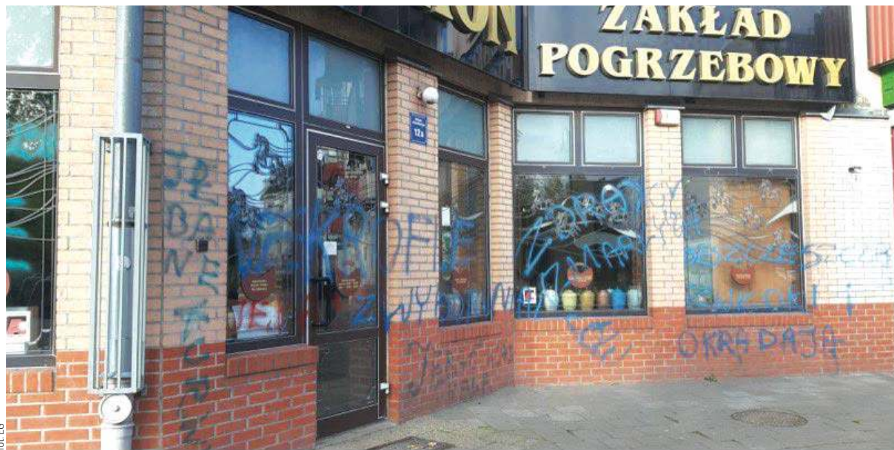
10 października siedziba zakładu została zdewastowana
