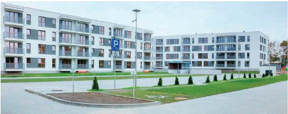
Na Osiedlu Foksal przy ulicy Firlejowskiej 2 powstanie kolejny, czwarty budynek mieszkalny
