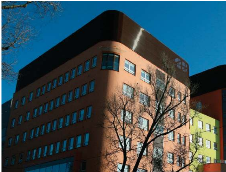
Dokończenie idącej jak po grudzie budowy budynku Zespołu Poradni Specjalistycznych nr 1 COZL to pierwszy znaczący sukces prof. Elżbiety Starośławskiej po jej powrocie, w marcu 2019 roku, na stanowisko dyrektora COZL
