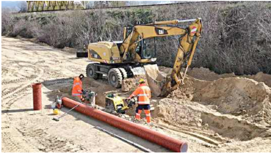
Trasa S19 będzie przebiegać po zachodniej stronie Lubartowa. Codziennie na budowie pracuje ok. 500 osób
