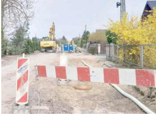
Dzięki inwestycji znacząco poprawią się warunki życia oraz standard infrastruktury technicznej w gminie Stężycza
