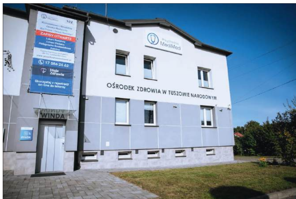
Budynek nowego ośrodka zdrowia.
