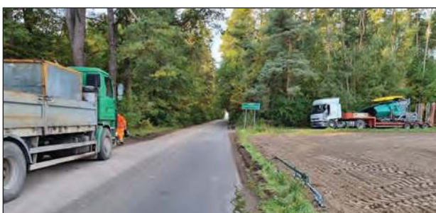
Prace na tych trzech odcinkach prowadzi spółka Fedro z Osiecka, która wyceniła swoje usługi na łączną sumę ponad 330 tysięcy złotych
