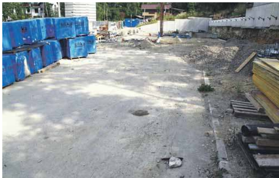
Budowa komisariatu policji rozpoczęła się we wrześniu ubiegłego roku.
