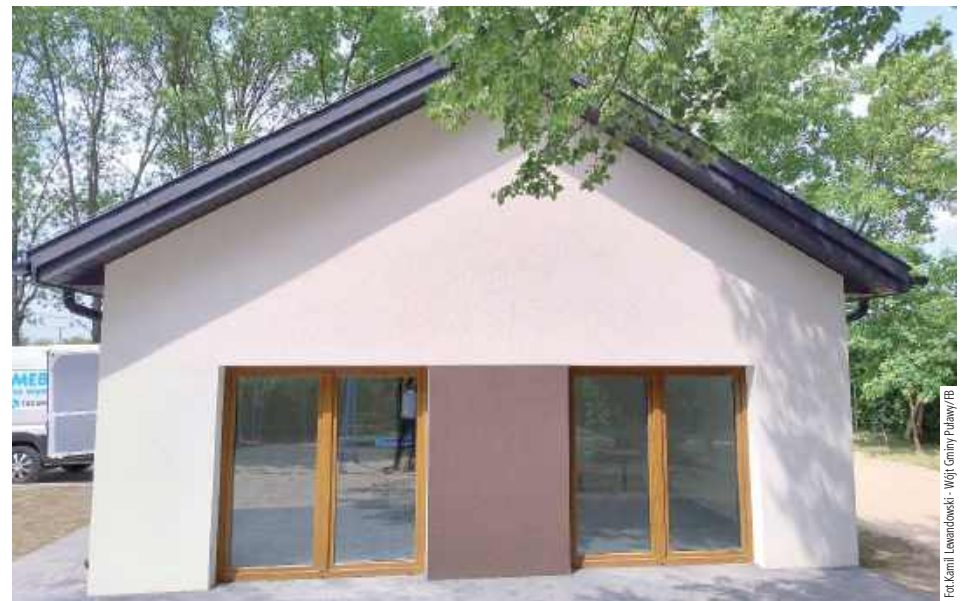
Budynek nowej świetlicy w Piskorowie nie przypomina obiektu sprzed remontu
