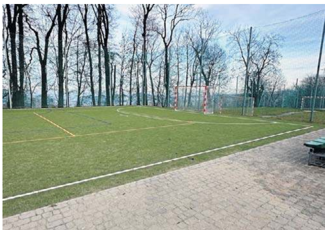
Wykonano modernizację boiska wielofunkcyjnego. Wartość inwestycji wyniosła 272 tys. 935 zł
