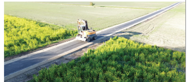
Prace w ramach zagospodarowania poscaleniowego w miejscowości Wygoda
