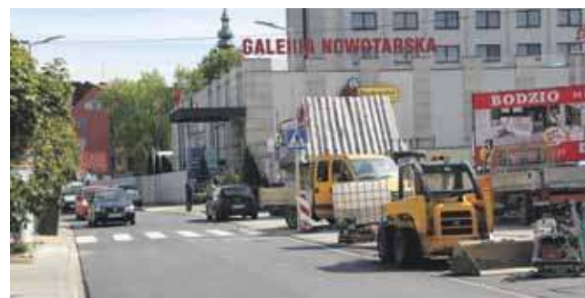
Ul. Królowej Jadwigi z nową nawierzchnią.
