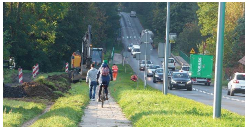
Na drodze 51 ruszyła budowa ronda koło Dywit
