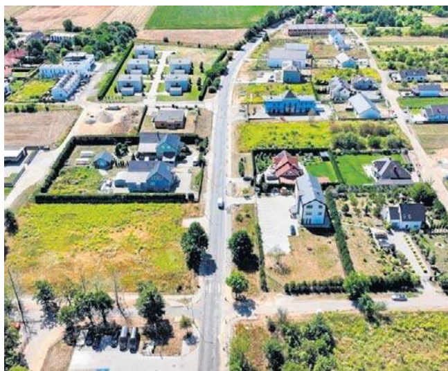
Ścieżka poprowadzi koło Wodociągów do granicy miasta
