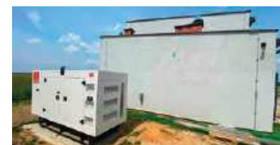
Trwa przebudowa stacji w Cholewach
