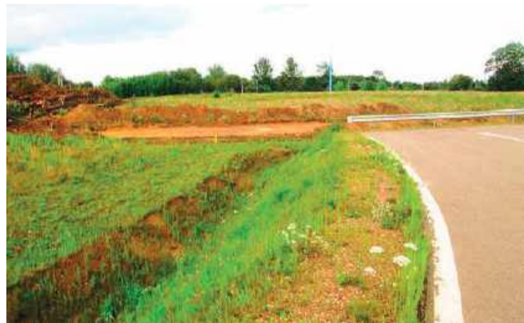
Początek prac przy obwodnicy przy wiadukcie w Modle
