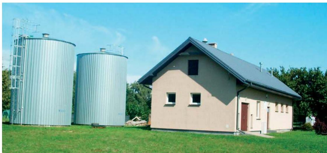
Rzut oka na studnię i stację uzdatniania wody w Wiśniewie
