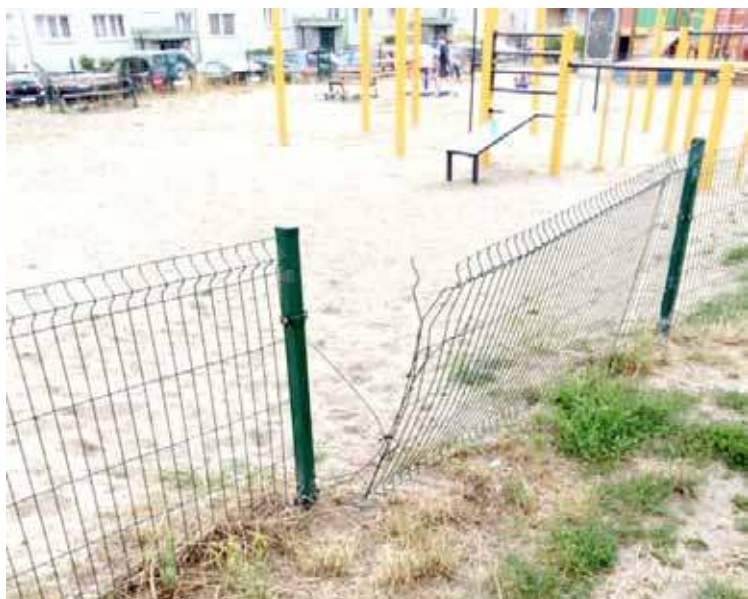
Wandale niszczą również ogrodzenia placów zabaw
