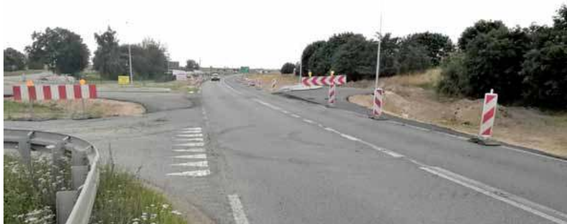
Na ulicy Broniewskiego w okolicy nowo budowanego ronda zostanie wprowadzony ruch wahadłowy
