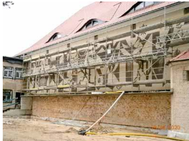
Odnawiany jest mural na zewnętrznej ścianie budynku
