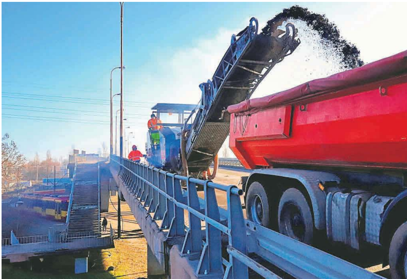
Tak wyglądają prace remontowe na wiadukcie na łódzkiej Dąbrowie
