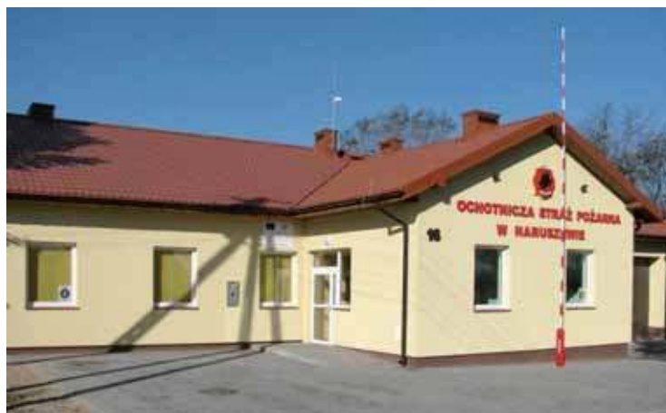
Remont remizy OSP Gmina Naruszewo
