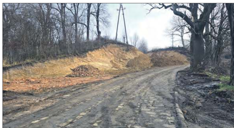
Prace przy nowej drodze, która połączy ulicę Nyską z Meblarską i Przemysłową
